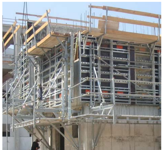
Figura 1 - Sistema di costruzione a cassero rampante. I casseri sono fissati alle pareti e, dopo il getto, smontati e sollevati in una posizione più alta, quando il calcestruzzo presenta una resistenza sufficiente (foto da Internet)
