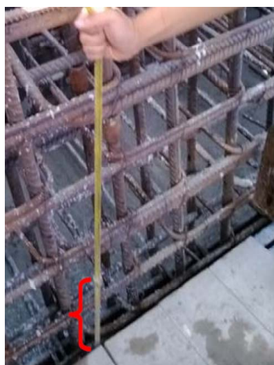
Figura 9 - Il plunger o ago, consente di misurare la distanza dal fondo dello strato in fase di presa
