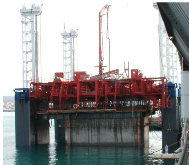
Figura 3 - Uso di slipform per costruire cassoni a mare. Il cassero viene sollevato progressivamente mediante 4 gru. Non si impiegano le barre di sollevamento [4]
