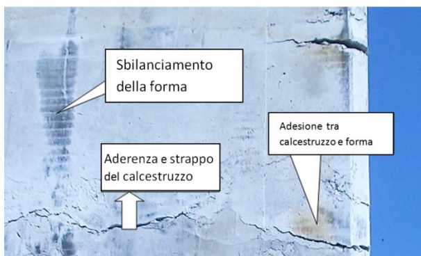
Figura 5 - Difetti dovuti a trascinamento e strappo
